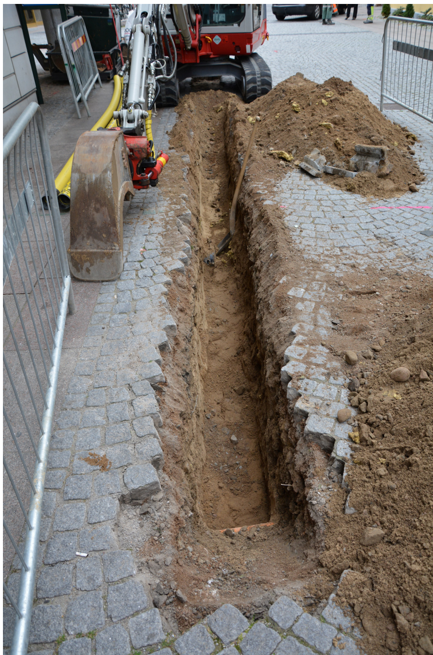
Figur 4. Bilden visar norra delen av det långa schaktet. Fyllningen bestod av grus som påförts vid tidigare ledningsarbeten.
