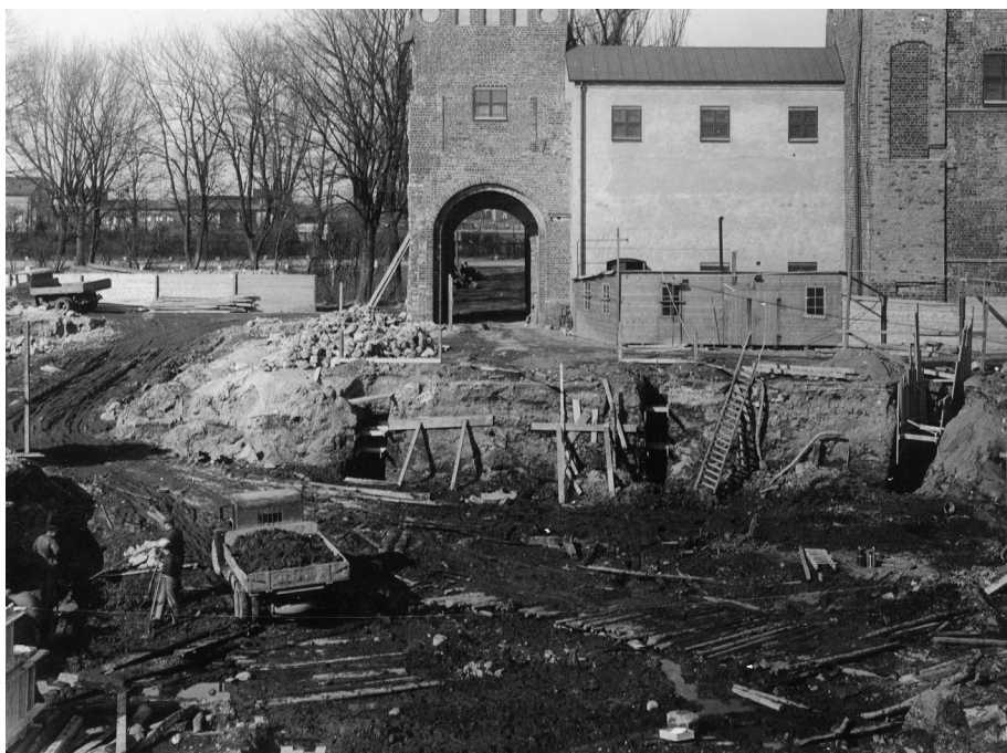
Figur 4. Fotografiet visar urschaktningen inför den nya museibygnaden. Fotografen står ungefär där entrén är idag.
