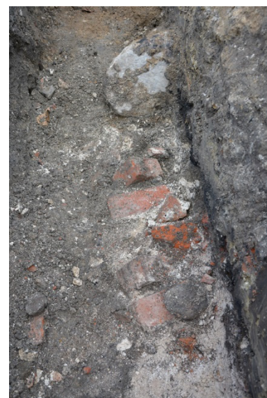
Figur 4. Fotot visar stengrunden som framkom i VA-schaktet. Flera av tegelstenarna låg tillsammans som en omkullvält mur.
