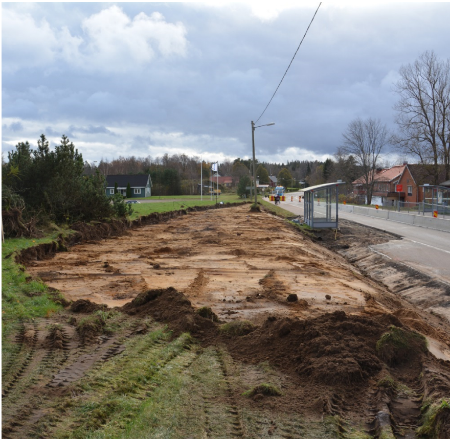
Figur 5. Foto över schaktet från norr.
