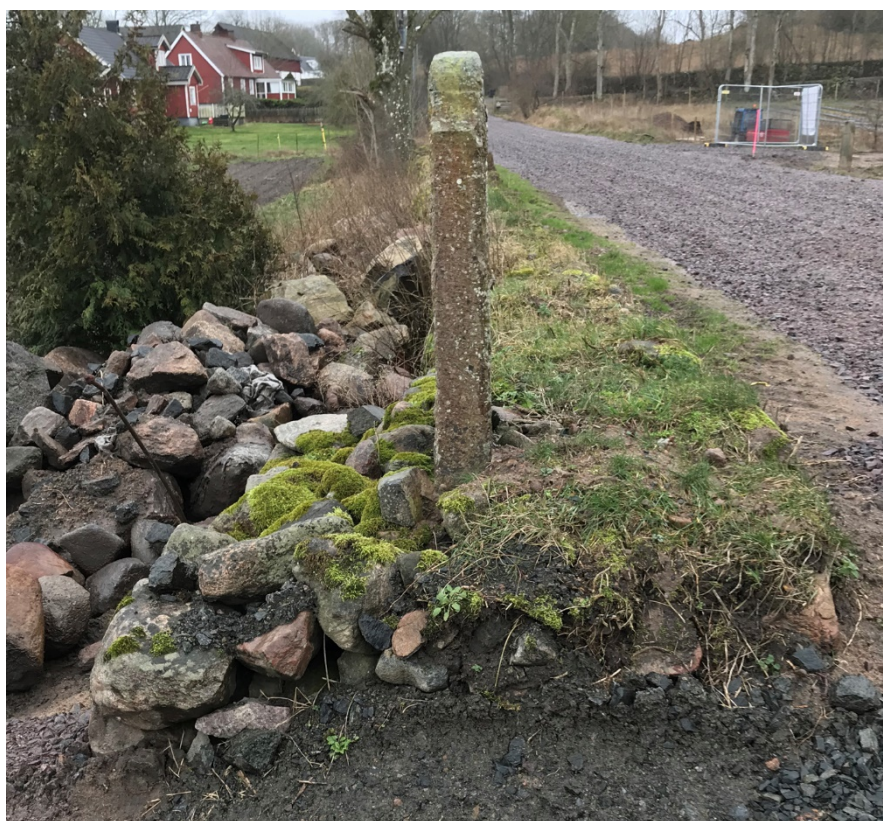
Figur 4. Den milstolpe som står i Röinge by kan inte stå i ursprungligt läge. Vägbanan till höger i bild har höjts med ca en meter vilket innebär att milstolpen har stått alldeles för högt. Milstolpen förefaller dessutom vara satt strax till vänster om stenmuren som löper längs med vägen och sedan har man byggt upp ett halvt fundament vänster om stenmuren. Foto från norr.
