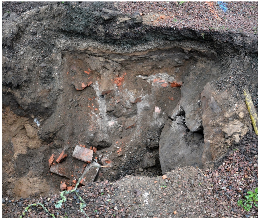
Figur 3. Fotot visar södra sidan av fundamentet. Till höger ses stora fältstenar som utgjorde västra kanten. Stenarna i den östra kanten har tagits bort av grävmaskinen. I mitten ses kärnan av kalkbruk och tegel. Foto från norr.
