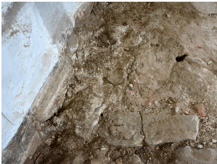
Figur 14. Invid den norra långhusmuren kunde man på ett par ställen se avtryck efter stenar i kalkbruket.
