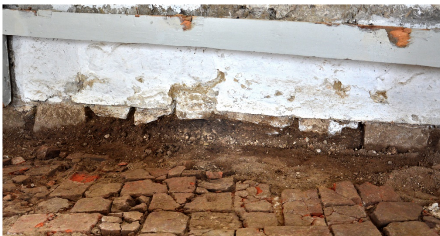
Figur 15. Den igenmurade sydportalens läge avslöjades genom att långhusgrunden vid portalen utgjordes av vanliga gråstenar istället för fint huggna sandstenar.
