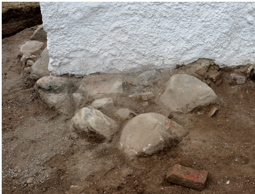
Figur 6. Stenpackningen som framkom under strävpelaren i kyrkans sydöstra hörn
