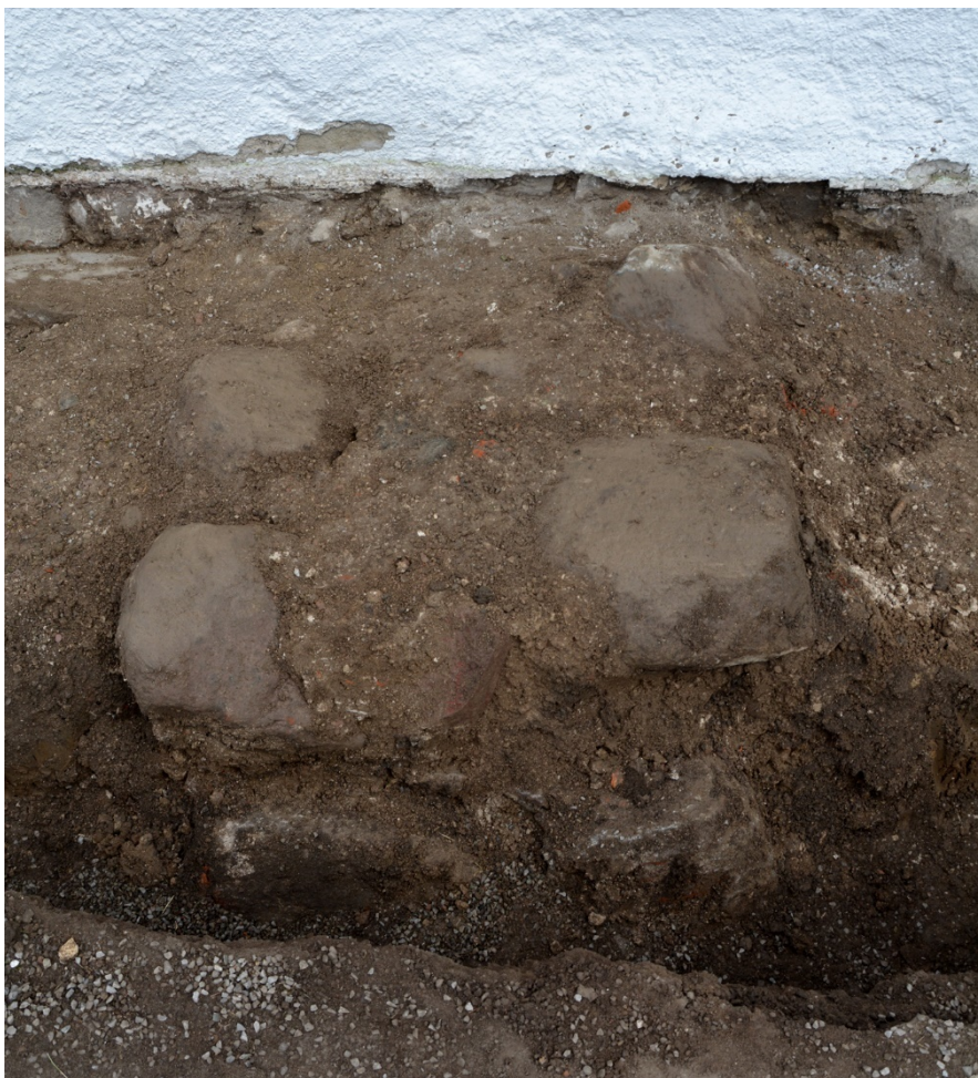
Figur 4. Fotot visar en rektangulär stenpackning med minst två skift gråsten. Konstruktionen är troligen rester efter en äldre strävpelare.
