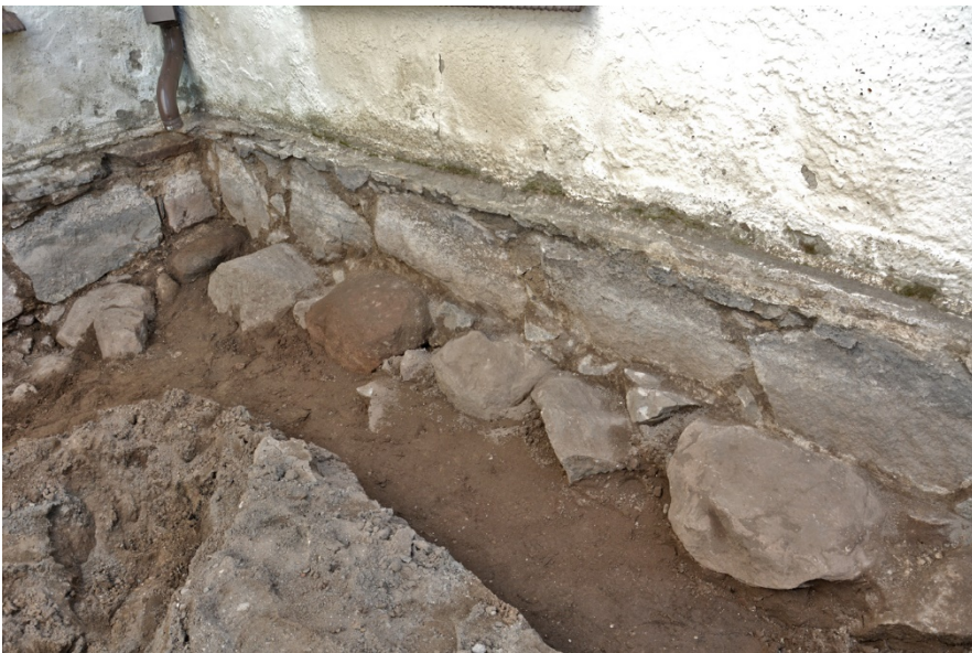
Figur 5. Fotot visar hörnet mellan tornet och södra långhusväggen. Foto från sydost.
