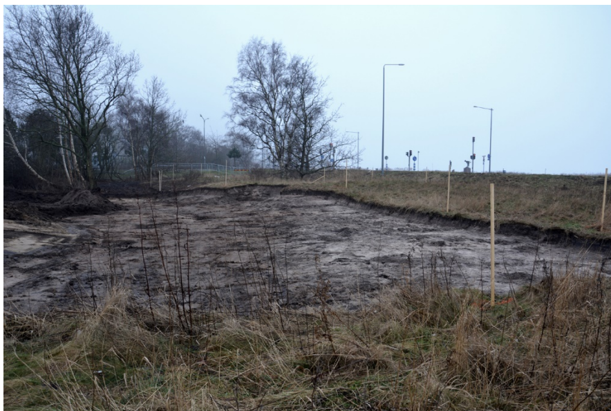
Figur 5. Översiktsbild över det dokumenterade schaktet. Foto från norr. Skansen befinner sig till vänster om den dominerande vägbanken för väg 100.
