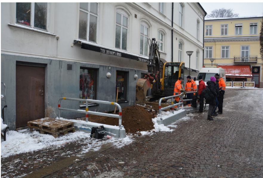
Figur 3. Översiktsbild över schaktet på Norra Kyrkogatan
